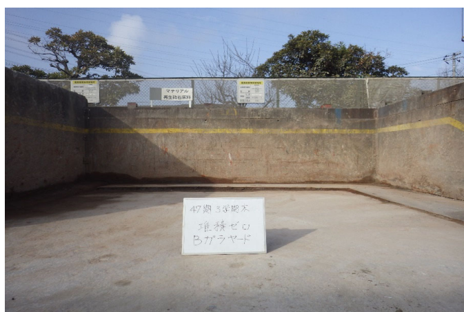
【4 がれき類 保管ヤード】
