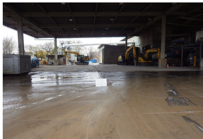
【1 混合廃棄物 選別ヤード】
