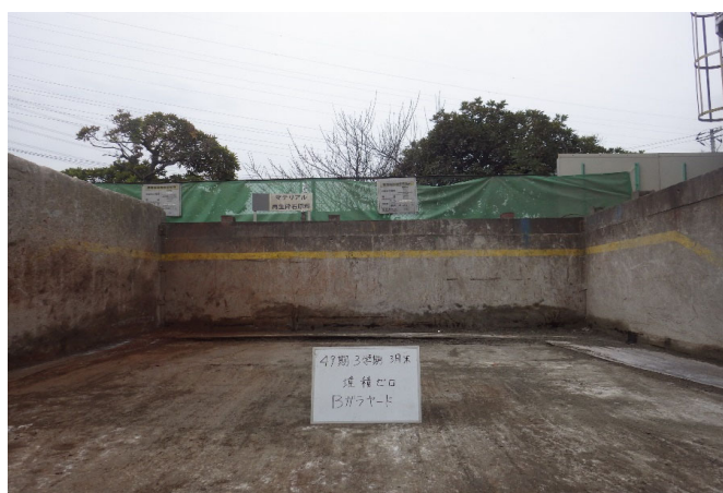
【4 がれき類 保管ヤード】
