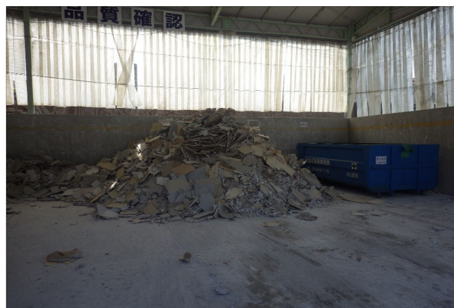
【3 石膏ボード 保管ヤード】
