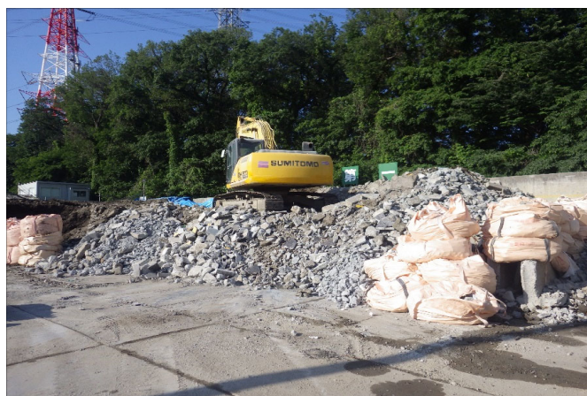
【4 がれき類 保管ヤード】
