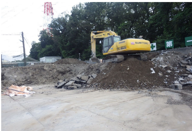
【4 がれき類 保管ヤード】
