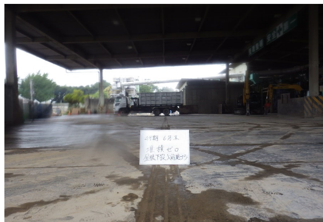
【1 混合廃棄物 選別ヤード】
