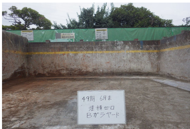
【4 がれき類 保管ヤード】
