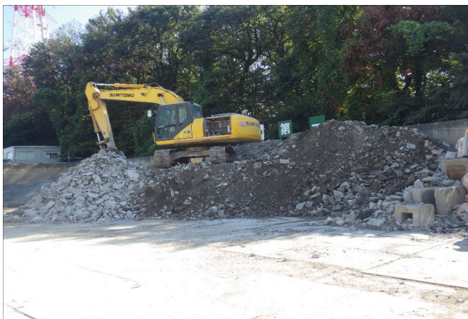
【4 がれき類 保管ヤード】
