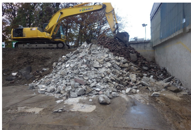
【4 がれき類 保管ヤード】
