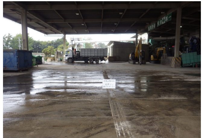
【1 混合廃棄物 選別ヤード】
