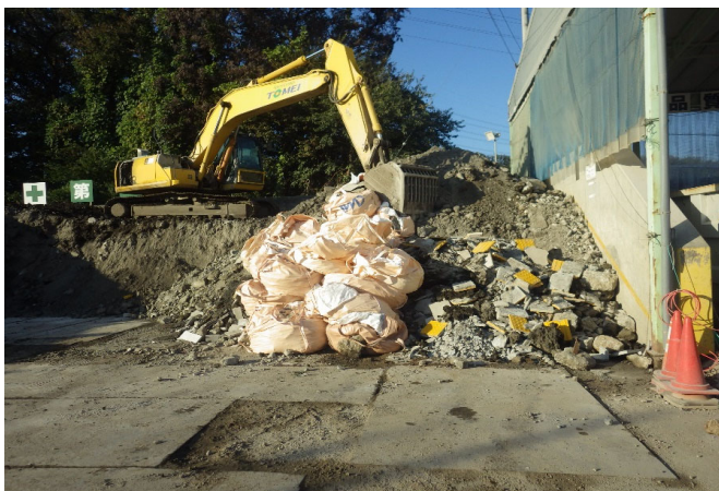
【4 がれき類 保管ヤード】
