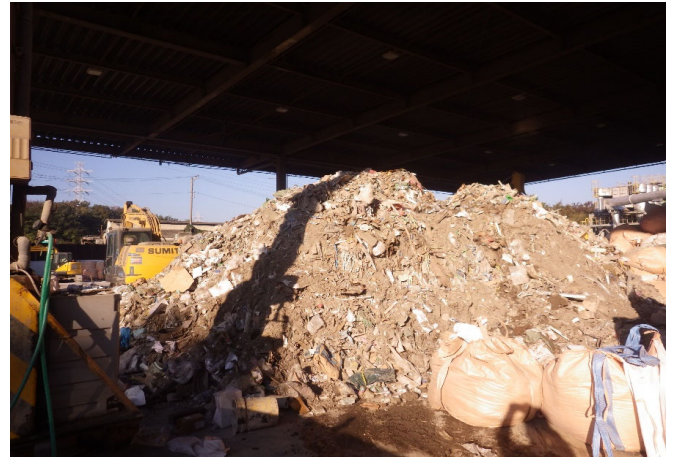
【1 混合廃棄物 選別ヤード】
