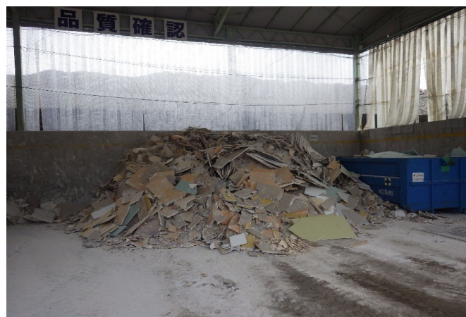
【3 石膏ボード 保管ヤード】
