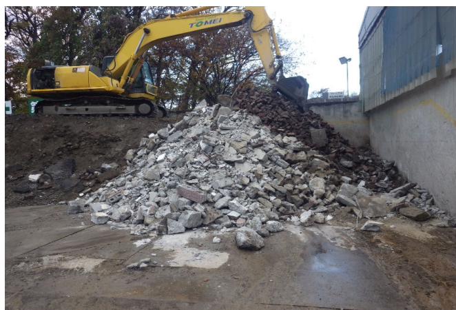
【4 がれき類 保管ヤード】
