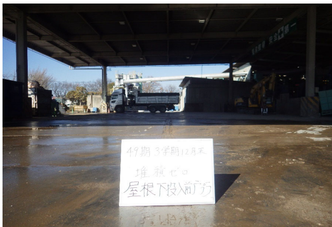
【2 廃プラスチック 選別ヤード】
