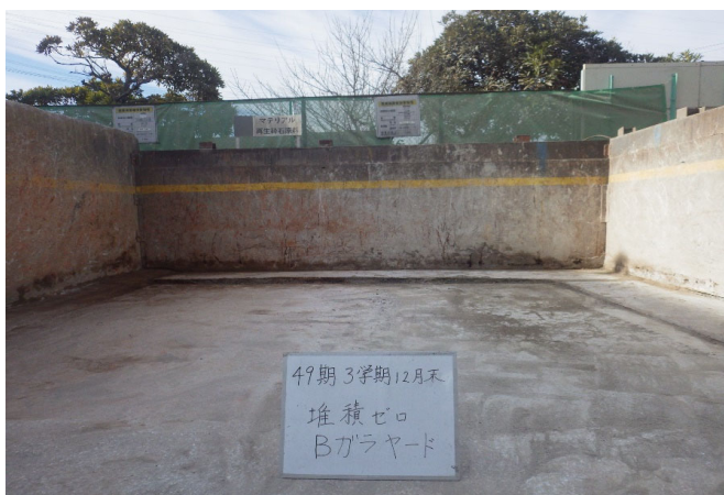
【4 がれき類 保管ヤード】
