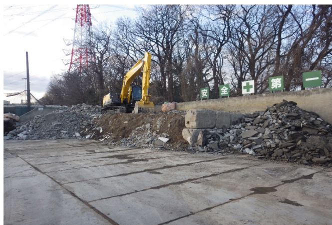
【4 がれき類 保管ヤード】
