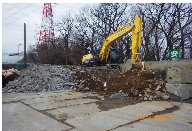
【4 がれき類 保管ヤード】
