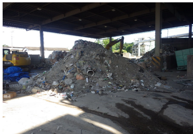
【1 混合廃棄物 選別ヤード】
