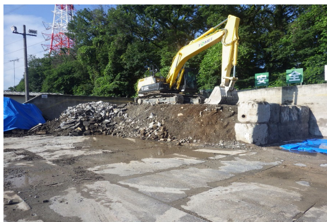
【4 がれき類 保管ヤード】
