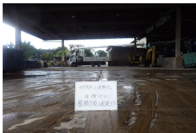
【2 廃プラスチック 選別ヤード】
