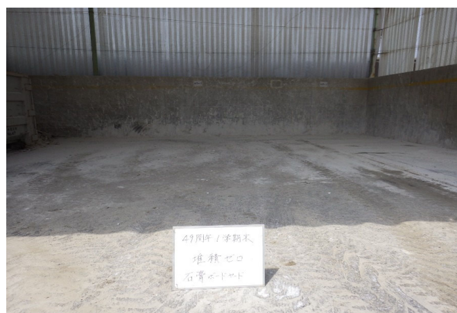
【3 石膏ボード 保管ヤード】
