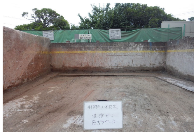
【4 がれき類 保管ヤード】
