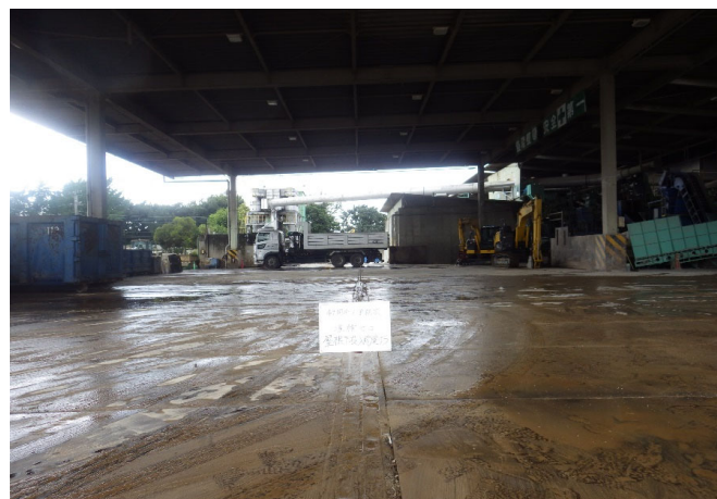
【1 混合廃棄物 選別ヤード】
