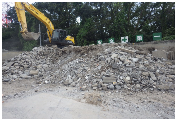
【4 がれき類 保管ヤード】
