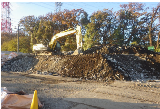
【4 がれき類 保管ヤード】
