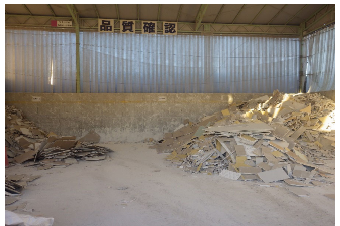
【3 石膏ボード 保管ヤード】
