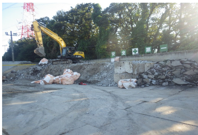
【4 がれき類 保管ヤード】
