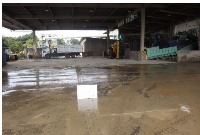
【2 廃プラスチック 選別ヤード】
