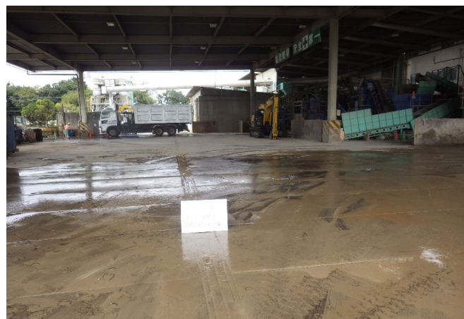
【1 混合廃棄物 選別ヤード】
