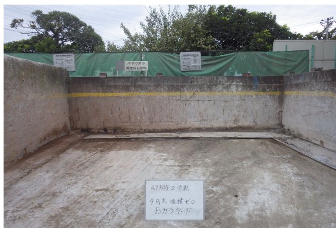
【4 がれき類 保管ヤード】
