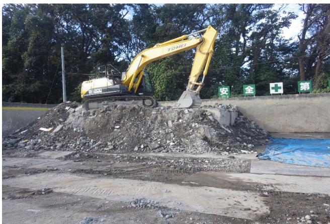
【4 がれき類 保管ヤード】
