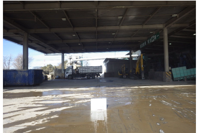
【1 混合廃棄物 選別ヤード】
