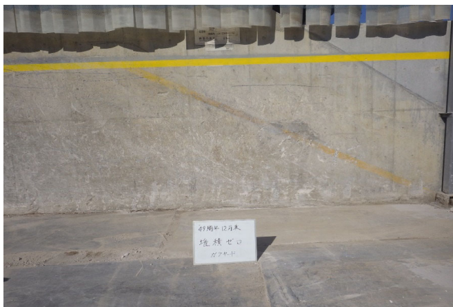
【4 がれき類 保管ヤード】
