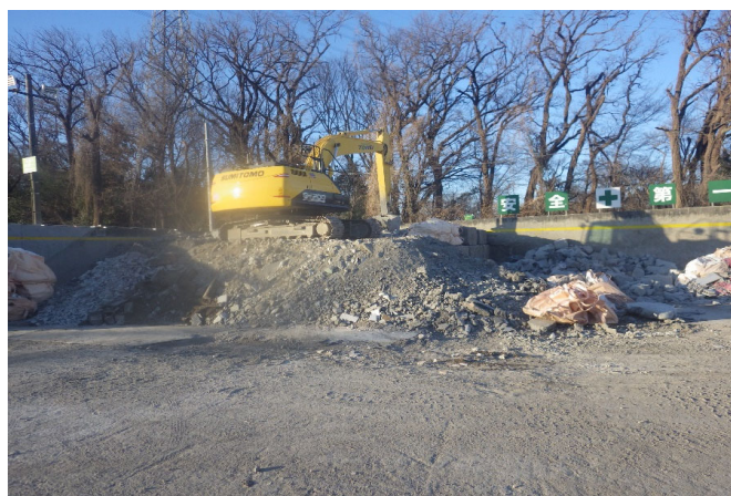
【4 がれき類 保管ヤード】
