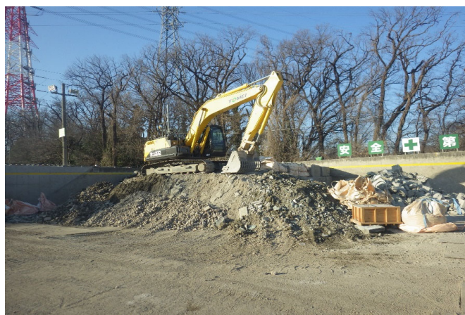
【4 がれき類 保管ヤード】
