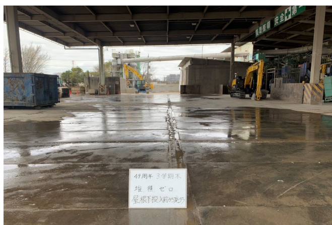
【2 廃プラスチック 選別ヤード】
