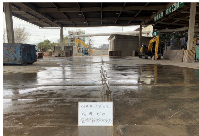
【1 混合廃棄物 選別ヤード】
