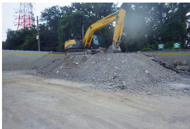
【4 がれき類 保管ヤード】
