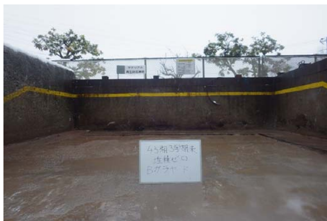
【4 がれき類 保管ヤード】
