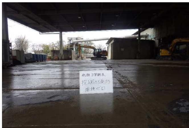
【2 廃プラスチック 選別ヤード】
