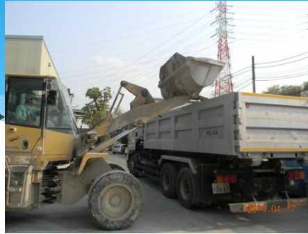
積み込みの状況
