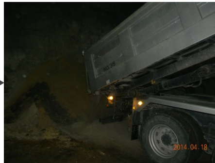
荷降ろし状況
