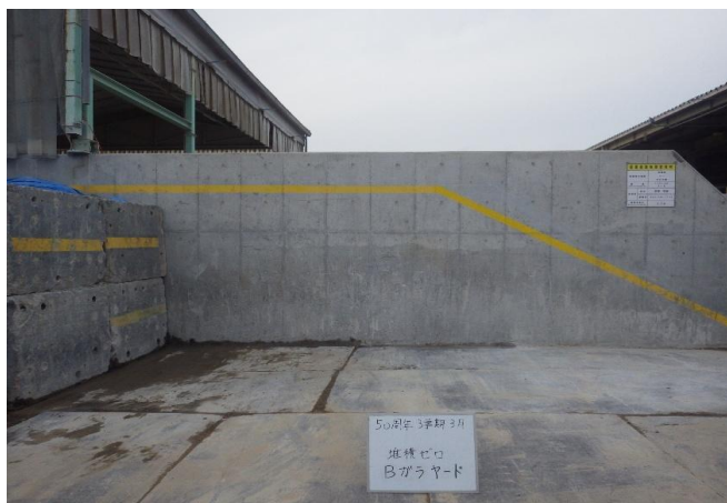
【5 がれき類 保管ヤード】
