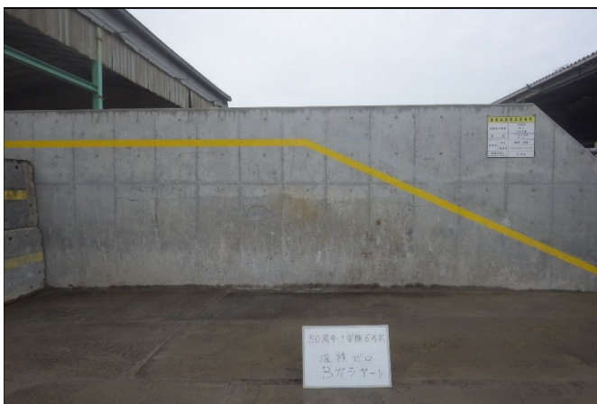
【5 がれき類 保管ヤード】
