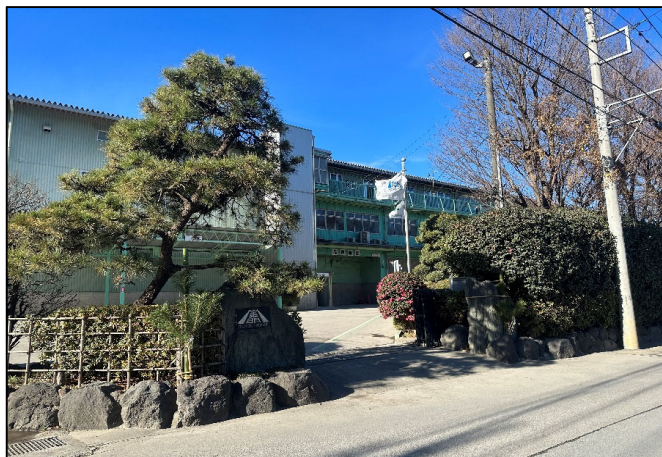
【1 中間処理施設 正門】
