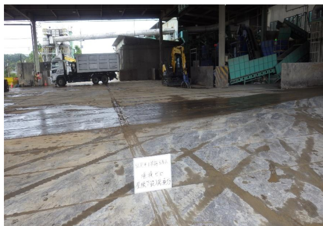
【2 混合廃棄物 選別ヤード】
