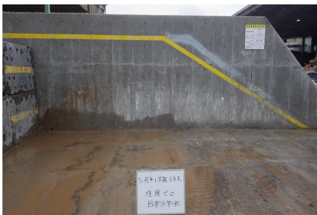
【5 がれき類 保管ヤード】
